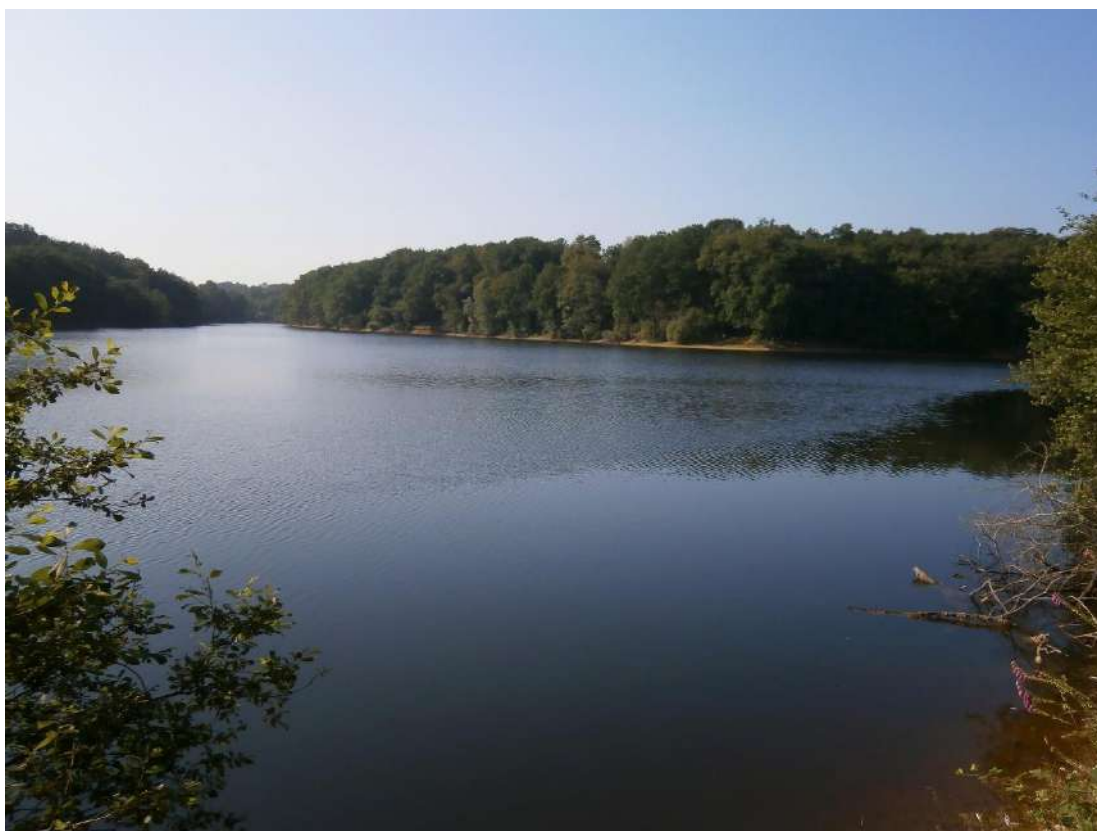
Barrage de Bazergues – commune de La Celle
