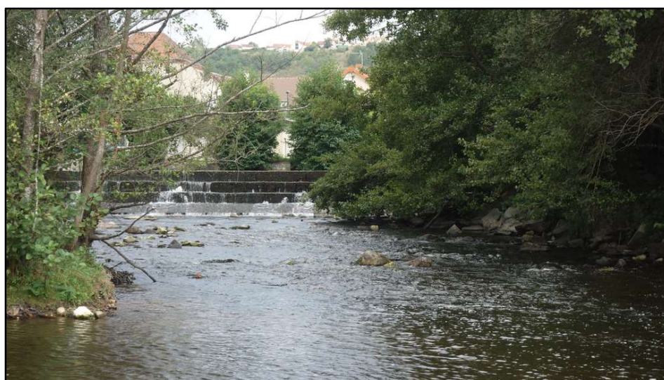
Aperçu de la station IAT « barrage Ebreuil »
