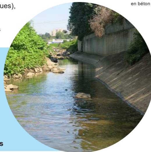
la rivière Yzeron (69) réduite en un canal artificiel avec des berges en béton
