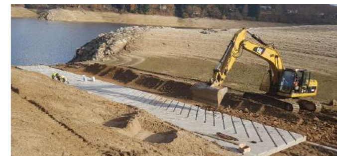
Travaux pour la mise à l'eau des embarcations sur le lac de Saint-Etienne-Cantalès
