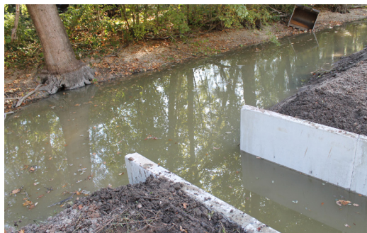
Frayère en eau après travaux
