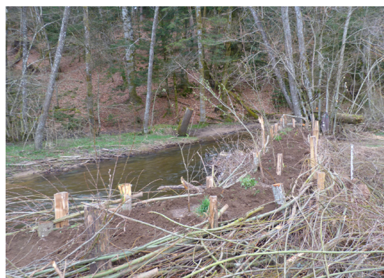
Protection de berge par techniques végétales
